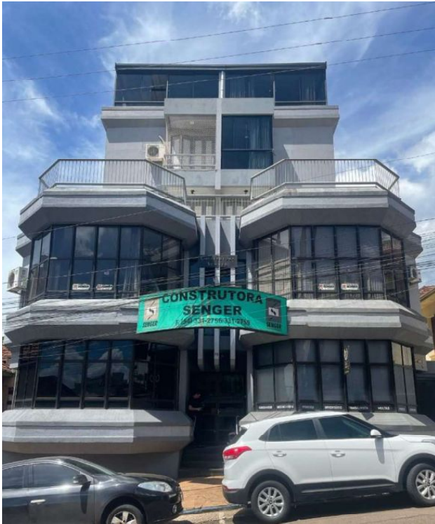
FACHADA DO PRÉDIO
